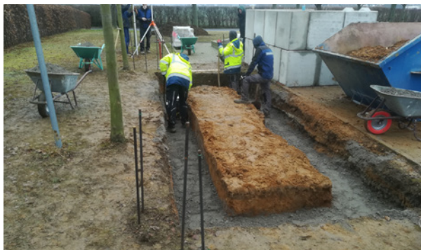
Einmessen eines Streifenfundamentes
