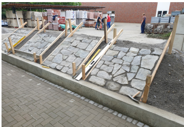
Herstellen von Böschungspflaster
