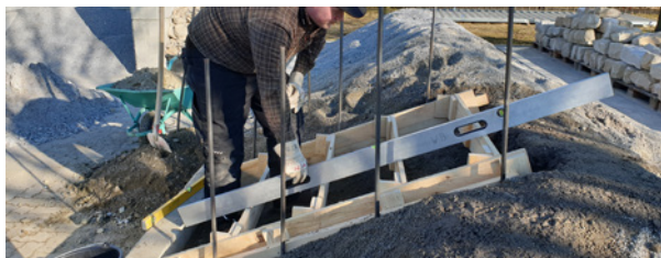
Herstellen einer Böschungstreppe
