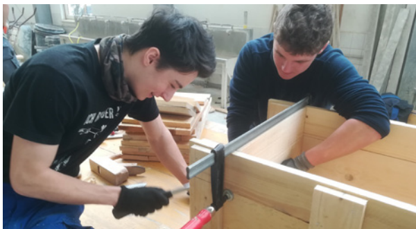
Herstellen einer systemlosen Schalung
