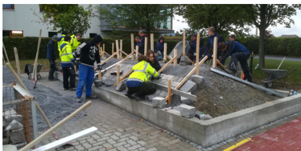
Herstellen von Böschungspflaster
