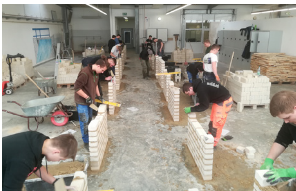
Herstellen einer Mauer
